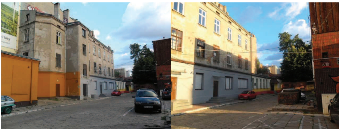
Pozostałości po posesji przy ul. Andrzeja 6
