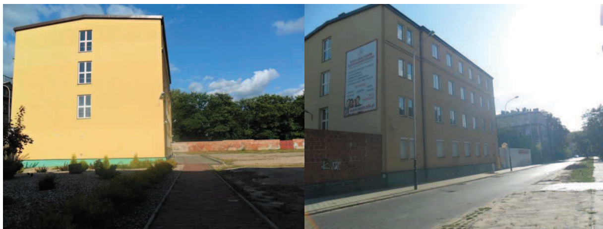
Pozostałości po zabudowaniach posesji przy ul. Senatorskiej 7/9
