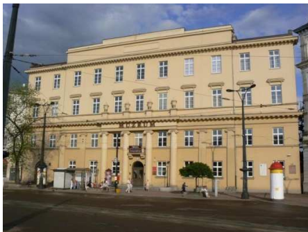
Budynek Łódzkiej Wyższej Szkoły Rzemieślniczej po przebudowie w 1884 roku (u góry), (obecnie Muzeum Etnograficzne i Archeologiczne, Pl. Wolności 14)[5,6]
