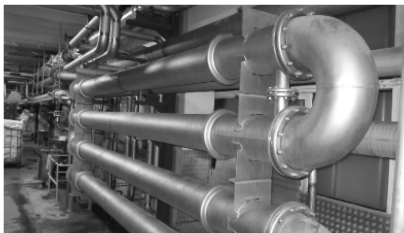
Rys. 6. Wymiennik ciepła typu rura w rurze firmy Dofama Thies s. z o.o. [Zdjęcie własne].
